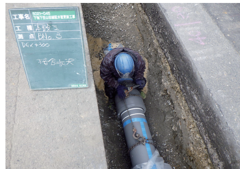
配水管の取りかえの様子
