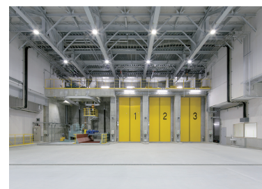
↑ プラットホーム
